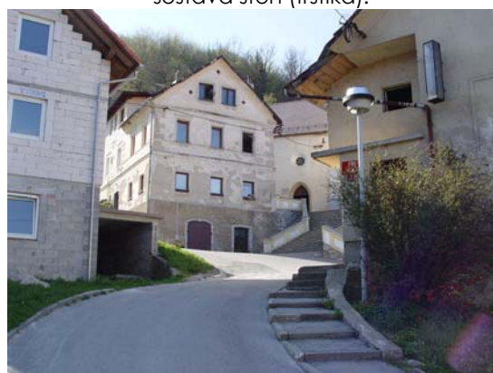
6. Najbolj izpostavljena fasada je na južni strani, kjer poteka tudi dostopna pot do objekta.
