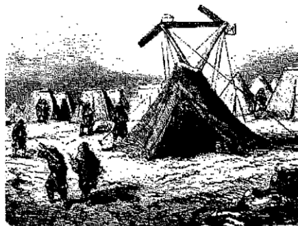
Slika 1-2. Chappe-ov telegraf v krimski vojnji, montiran na šotoru
