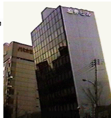
Globalna porušitev s plastifikacijo v prečkah
