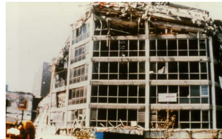
mehka etaža (soft storey)
