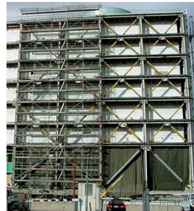
diagonale s preprečenim uklonom (buckling restrained braces)
