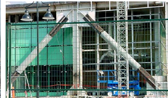
diagonale s preprečenim uklonom (buckling restrained braces)
