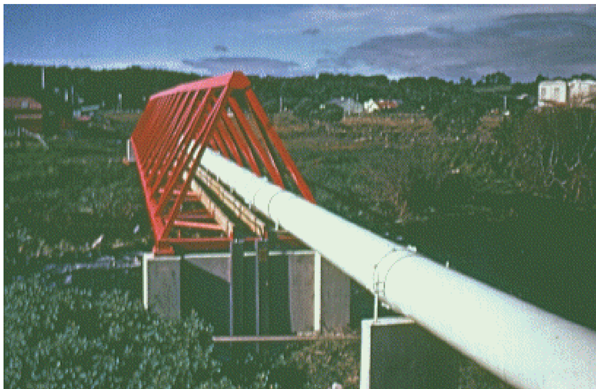
Most za razvod inštalacijskih vodov
