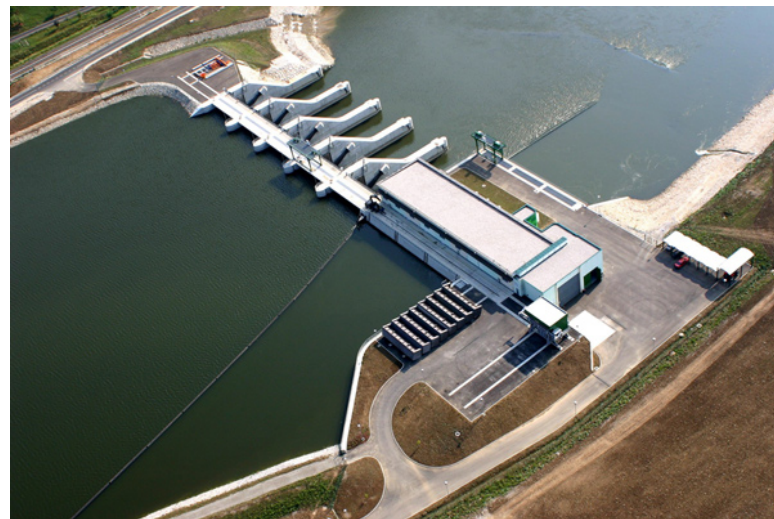
Pretočno akumulacijska elektrarna He Boštanj
