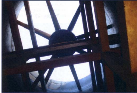
Pogled v notranjost hladilnega stolpa.
