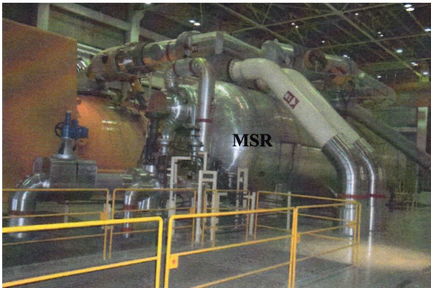
Slika 22: Izločevalnik vlage in dogrevalnik
