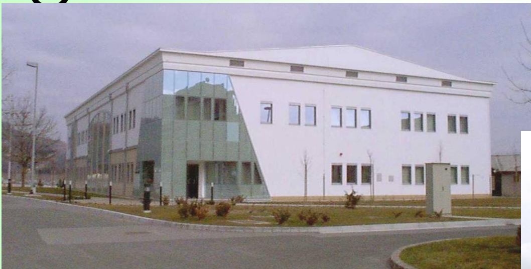
Zgradba Strokovnega usposabljanja
