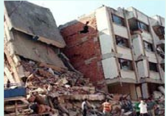
POŠKODOVANA STAVBA V INDONEZIJI
