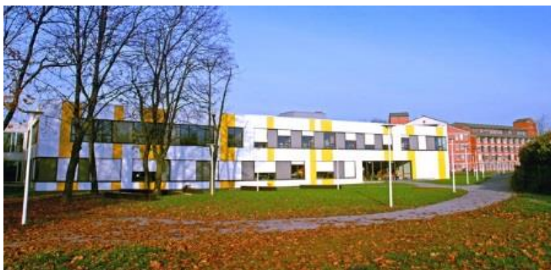
Slika 1: Pogled na najbolj barvit del osrednje stavbe zavoda, imenovan Marjetica (vir: http://www.ir-rs.si , 2015)
