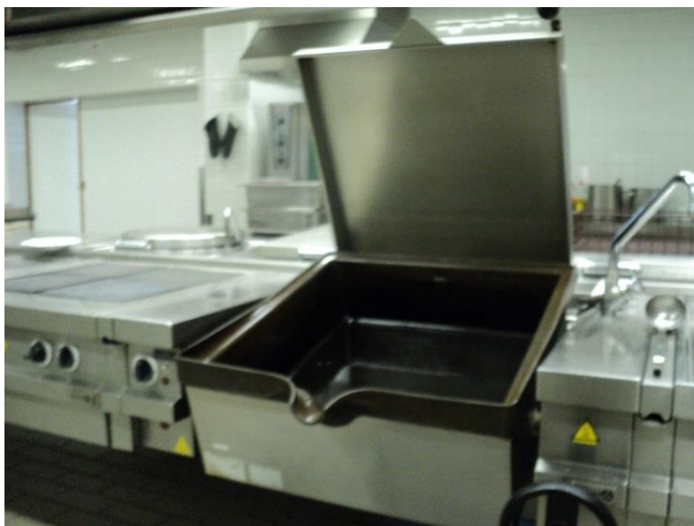
Slika 9: Električna toplotna naprava: prekucni kotel (vir: Matej Kolmanič, osebni arhiv)
