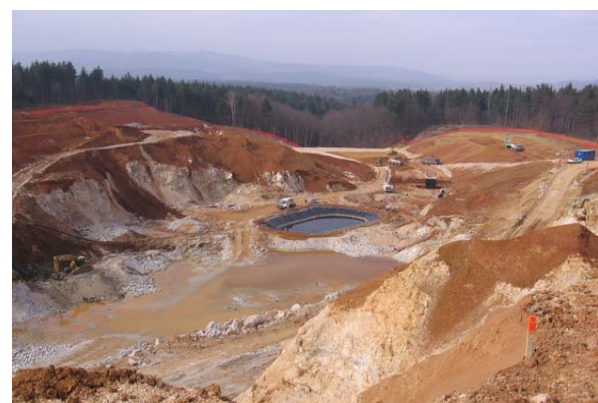
Priprava sklede novega dela odlagališča, marec 2006
