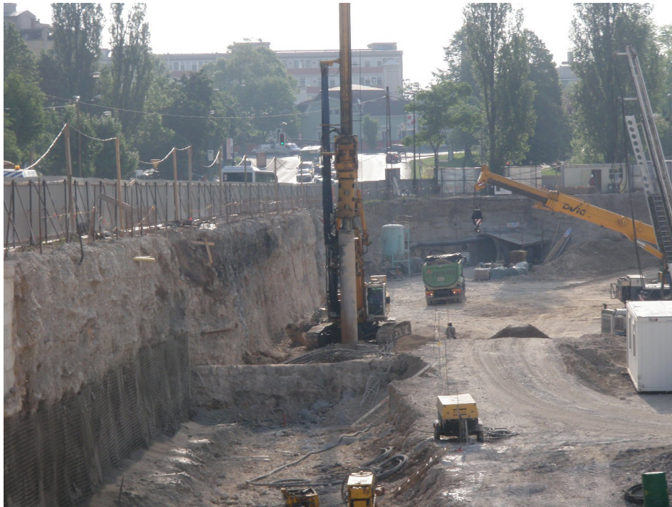
Slika 28. Gradnja velikega zadrževalnega bazena v Ljubljani
