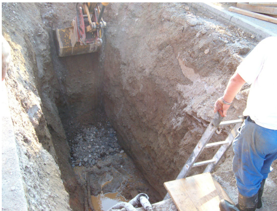
Slika 36. Gradnja v praksi
