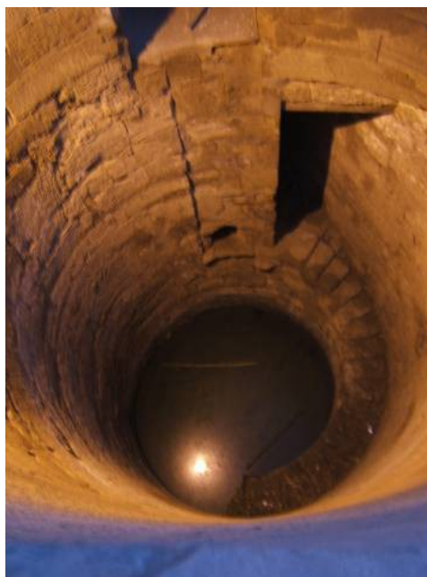
Slika 41: Kopani vodnjak (obzidava s kamni) Vir: Lasten
