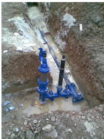
Slika 72: Podzemni hidrant (vgradnja). Pred hidrantom vidimo zasun, pa tudi T-kos, na desni strani zaprt s prirobniškim čepom, saj bodo od tod dalje nadaljevali s cevovodom. Vir: Lasten
