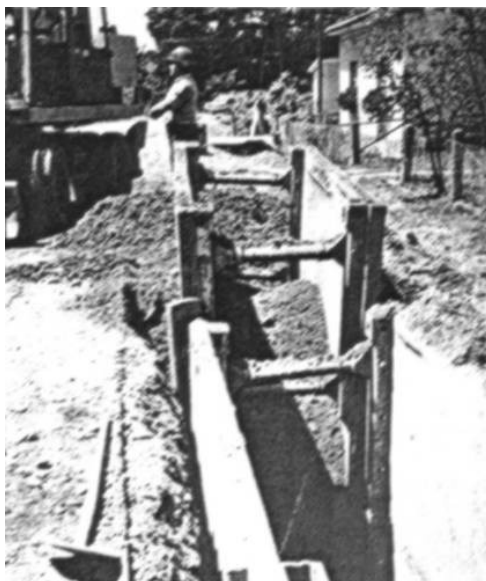
Slika 89: Varno polaganje cevi v izkopanem jarku z razpiranjem Vir: Lasten
