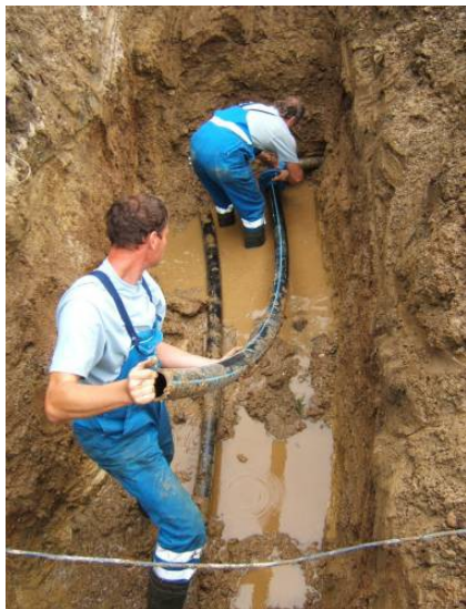
Slika 97: Zamenjava počene cevi vodovoda Vir: Lasten
