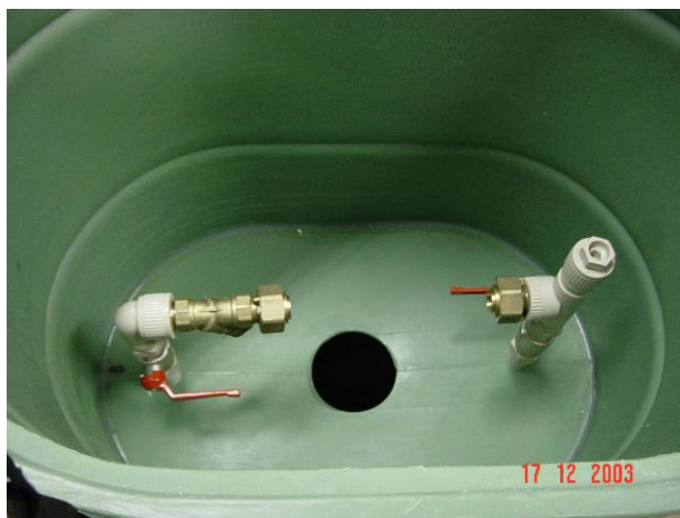
Slika 75: Montažni vodomerni jašek vodovodnega priključka Vir: Lasten
