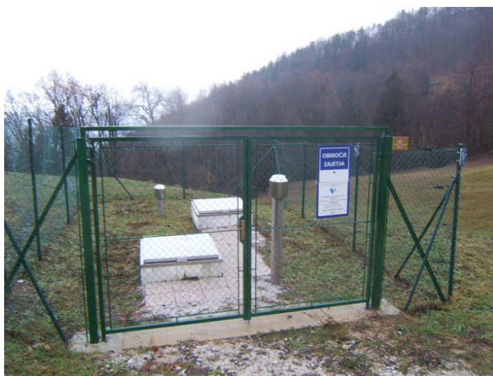
Slika 47: Preprosto črpališče z vrtanim vodnjakom Vir: Lasten
