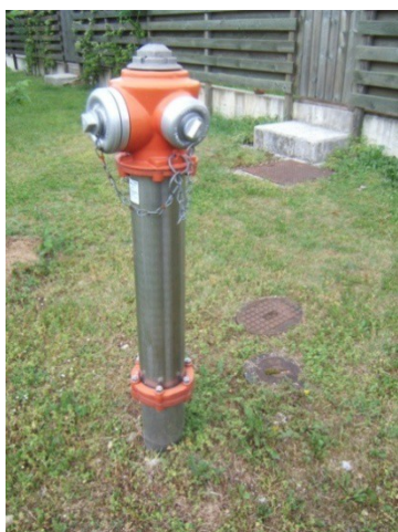
Slika 70: Nadzemni hidrant Vir: Lasten
