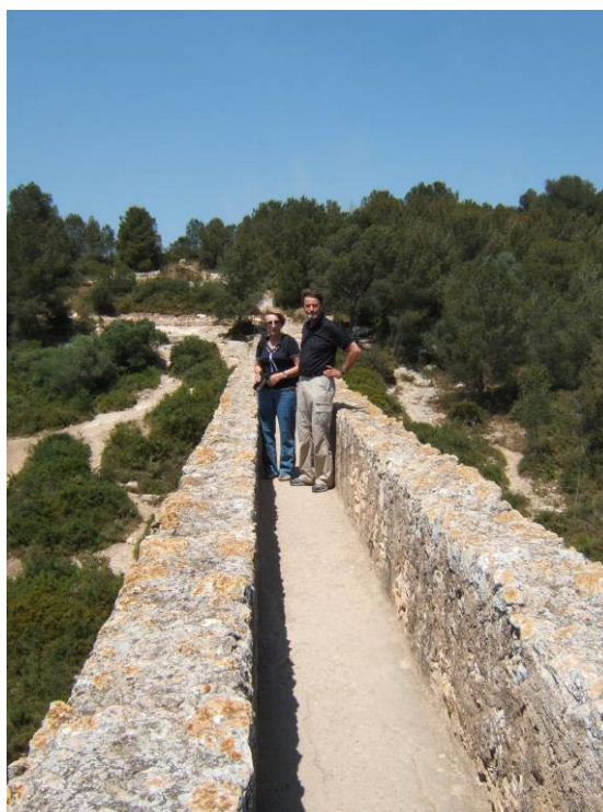
Slika 2: Fotografija rimskega akvadukta Vir: Lasten
