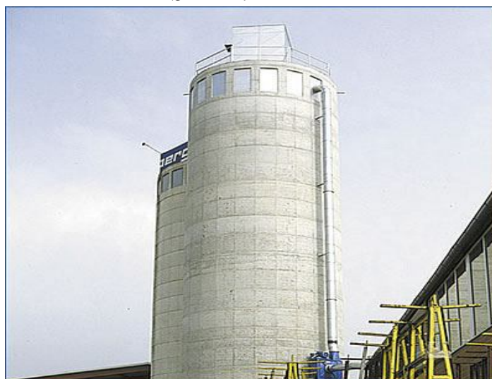
VELIK BETONSKI SILOS
